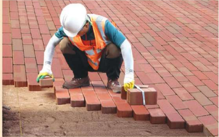
4. 기준선 설치 및 보도벽돌 깔기(보도벽돌 사이 간격 3mm유지)
