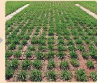
4. 황토플러스 잔디블록 시공 후
