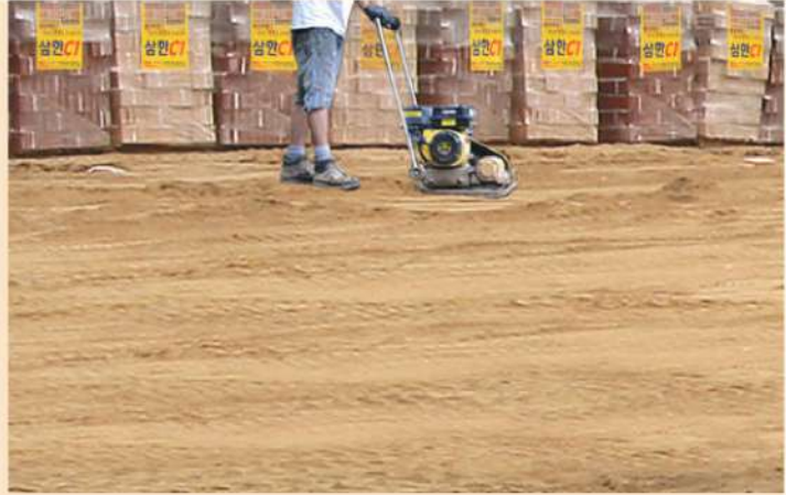
2. 살수 및 진동다짐 작업
